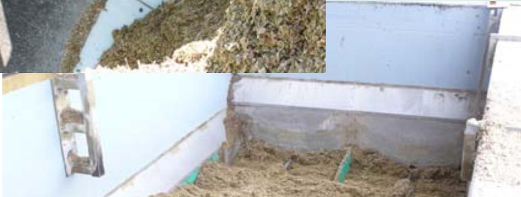
**Korrosion .... Saure Silage .. Auswirkungen am Eintrag sowie Austrag**
